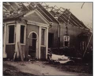
Iso-Heikkilän päärakennuksen purku.
